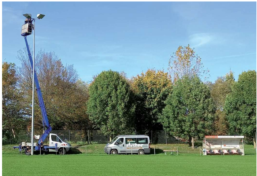
Die Installationsarbeiten für die neue Flutlichtanlage sind seit geraumer Zeit abgeschlossen.
